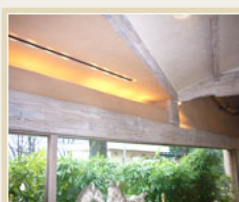
店舗内装・天井見上(1)
