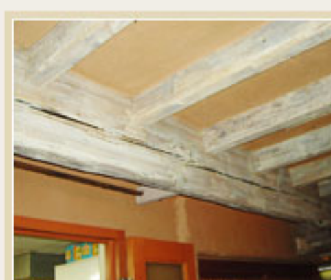
店舗内装・天井見上(2)
